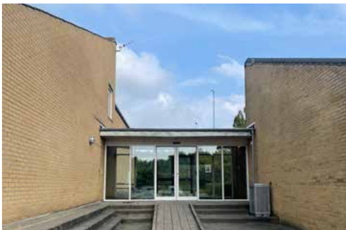
Fuldåbne glasfacader som indegnagsparti og bindeled.
